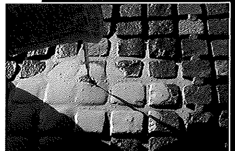
Verser le mortier de jointoiement sur les joints. Appliquer le produit dans les 20 minutes à une température de 20°C
